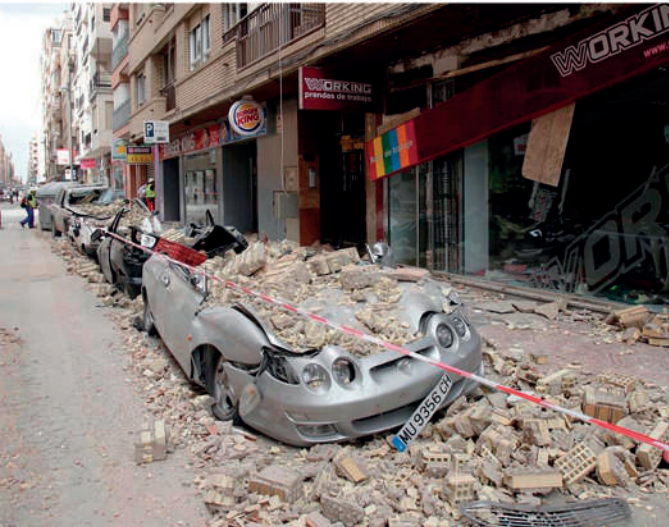
Une rue de Lorca (Espagne) après le séisme du 11 mai 2011. La majorité des dégâts sont concentrés sur les bords de la chaussée à cause de la chute d'éléments des balcons et corniches. Photo © Claudio Álvarez
