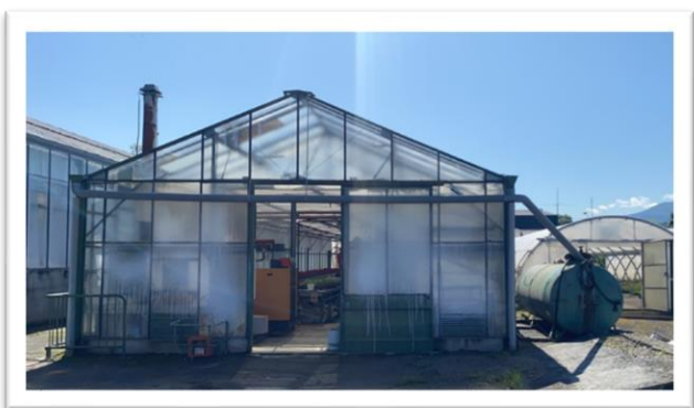
Installation d'une cuve pour la récupération des eaux de pluie
