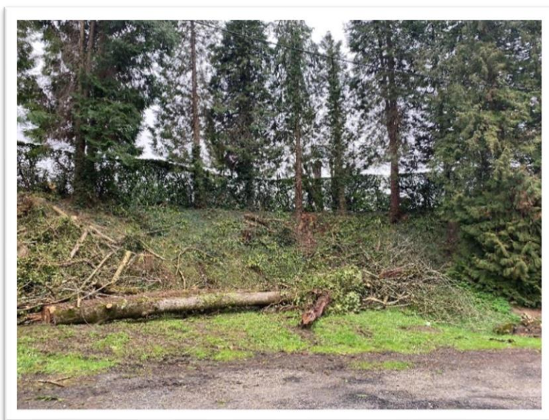
Abattage des arbres talus du Lapacca
