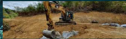
Création de fossés et d'ouvrage de franchissement des cours d'eau
