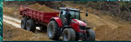
Mise au gabarit de pistes existantes
