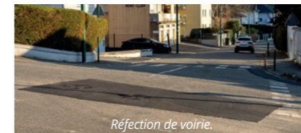
Réfection de voirie.
